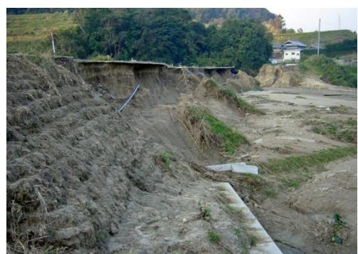
写真 4.6.2 越流による堤体の侵食
