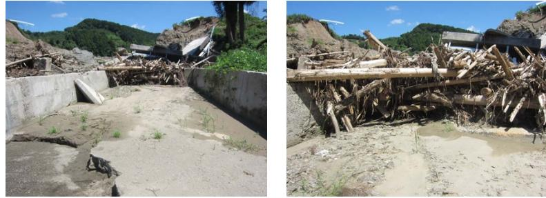
写真 4.2.4 流木で閉塞された洪水吐 山の神ため池（朝倉市）
