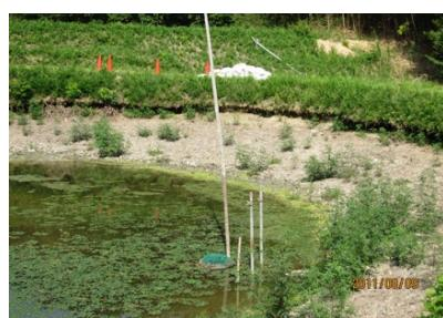
写真 4.3.1 浸透破壊したため池
