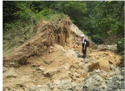
写真 4.1.6 堤体の破堤（勝負迫下池）
