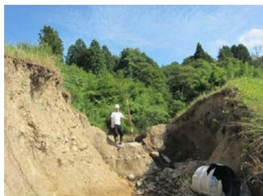
写真 4.2.1 越流によるため池の破堤 寺田池（東広島市）
