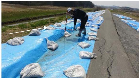
写真3.3-1 天端川表側に開口亀裂発生
