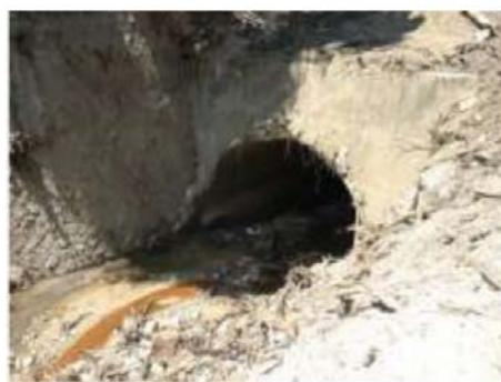
写真2.3-1 道路横断管の閉塞状況<sup>4)</sup>
