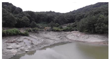
写真 4.1.3 堤内に流入した土砂（江田池）
