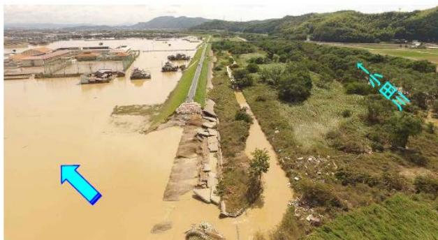
図3.5-1 小田川KP3.4での破堤状況<sup>1)</sup>
