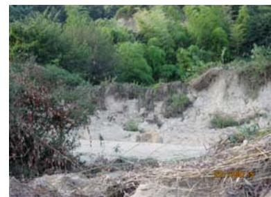
写真 4.2.3 越流による下流法面の侵食 (岡山市東区宝伝のため池)
