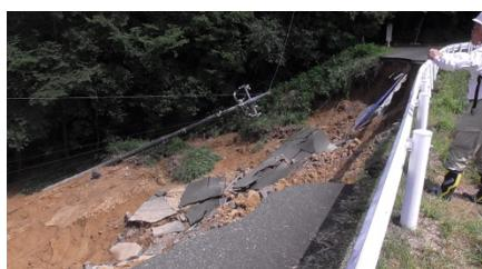
写真 4.1.1 堤体崩落（冠光寺池）
