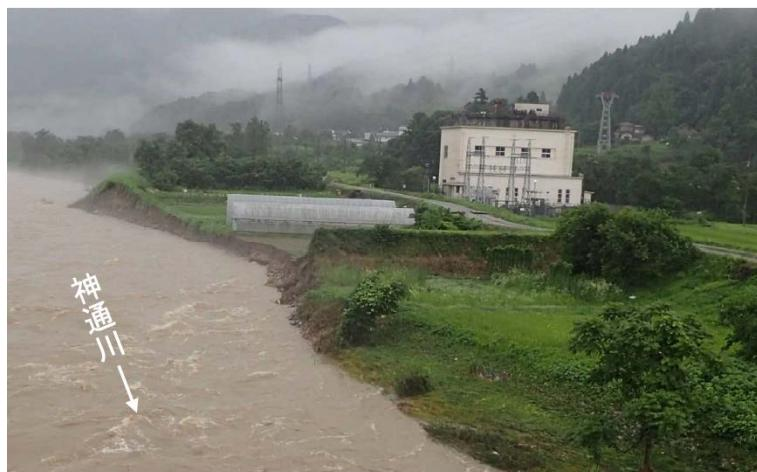
図3.5-4 神通川での側方侵食による堤防欠損<sup>3)</sup>
