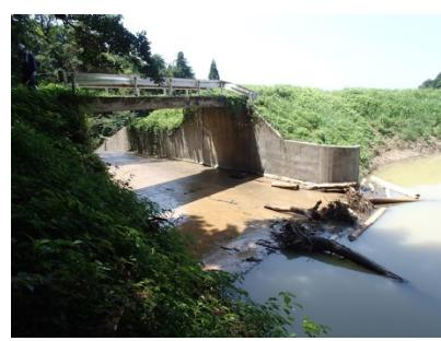
写真 4.4.1 洪水吐の閉塞状況（平成 30 年 7 月豪雨）
