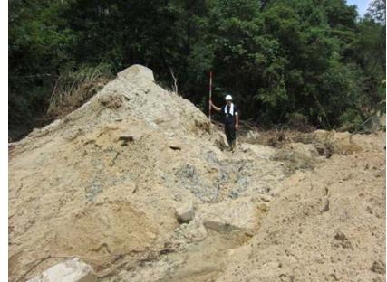
写真 4.1.5 堤体の破堤（勝負迫上池）
