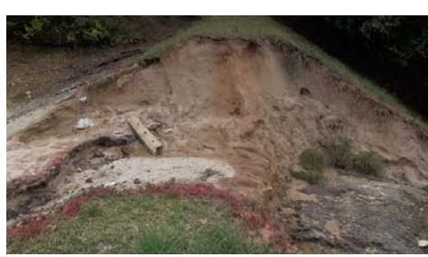
写真 4.2.2 越流によるため池の破堤断面 (向迫田ため池) (山県郡北広島町)
