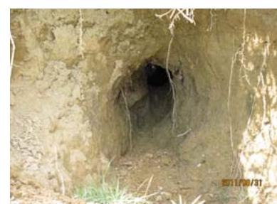
写真 4.3.3 浸透破壊を起こした穴
