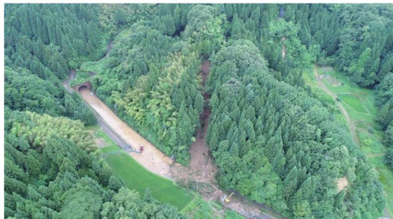
写真2.3-2 崩壊土砂がトンネル内に流入している状況<sup>5)</sup>
