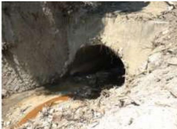
写真2.3-1 道路横断管の閉塞状況<sup>4)</sup>
