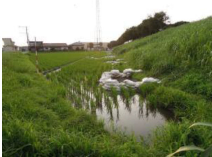
7月16日 のり尻陥没状況
