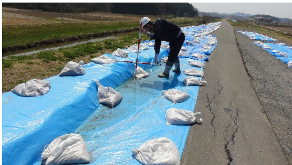
天端川表 側に開口 亀裂発生
