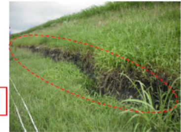
R7 右岸 11.8k 被災 (亀裂・陥没)
