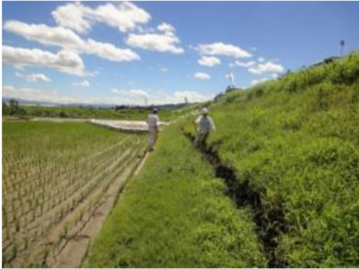
7月16日 のり尻陥没状況
