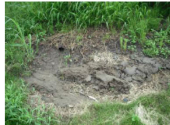
R2 右岸 6.0k 被災 (漏水)
