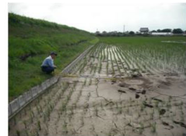
R7 右岸 11.8k 被災 (漏水)
