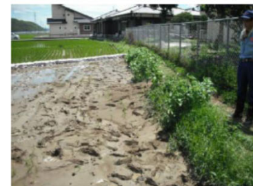
L6 左岸 16.0k 被災 (漏水)
