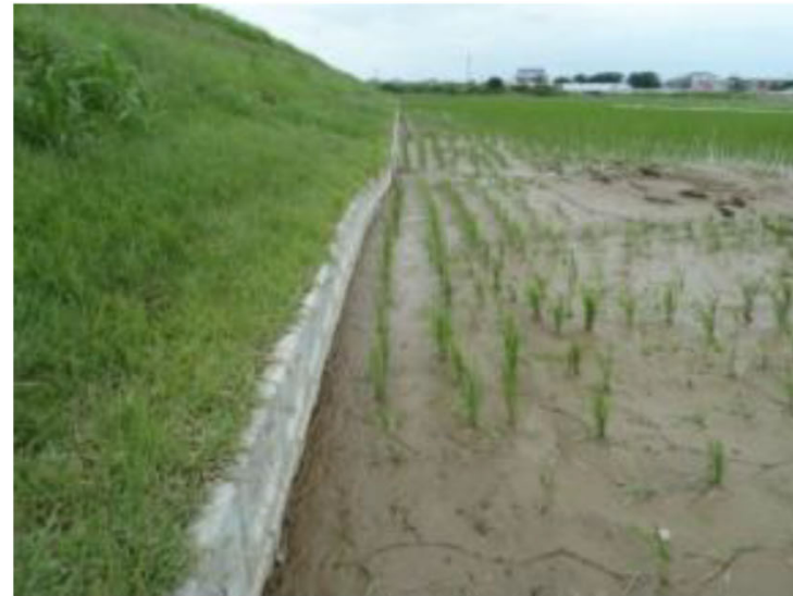
7月16日 堤内地 漏水状況①
