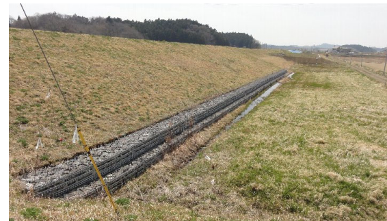
川裏側 には変 状なし
