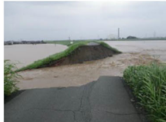
R4 右岸 7.3k 被災 (堤防決壊)
