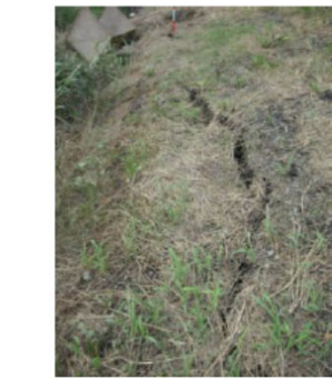
R6 右岸 11.0k 被災 (亀裂)
