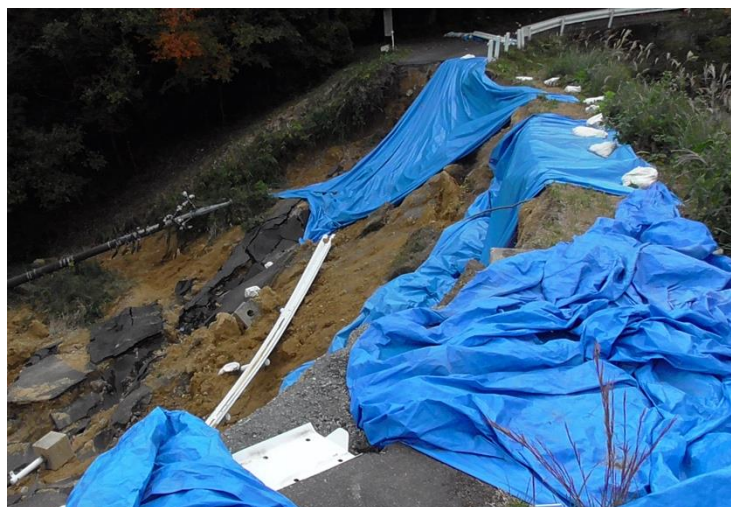
裏のり面のすべり破壊 近江谷中池（福山市赤坂町）
