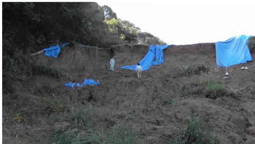
裏のり面のすべり破壊 近江谷中池（福山市赤坂町）
