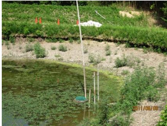
洗掘された上流面
