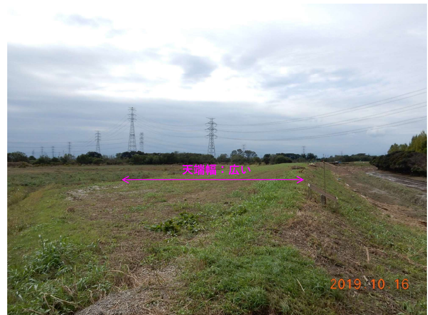
写真③：都幾川右岸0.4k付近（小剣樋管） ー 小剣樋管より下流側の堤防の状況ー
