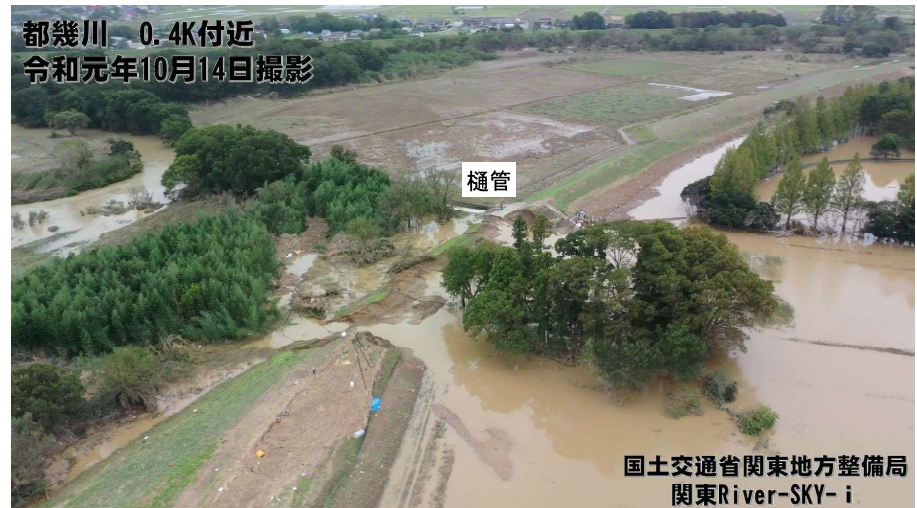
（下流側を望む）小剣樋管より上流側も幅は広い
