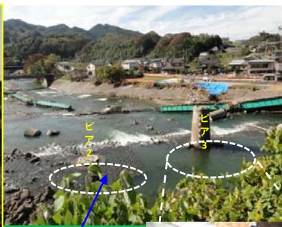
被災後のピア上流側設置ブロックは残っている
