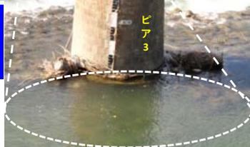
被災後のピア上流側設置ブロックなし
