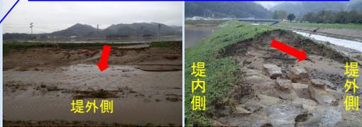
上流での河川氾濫に伴う堤内側の浸水に伴う破堤と推察される。通常の堤防の決壊とは逆方向の破堤。
