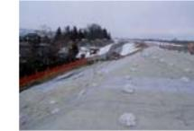
図-4 吸出防止材(縁切)設置状況(2008.3撮影)
