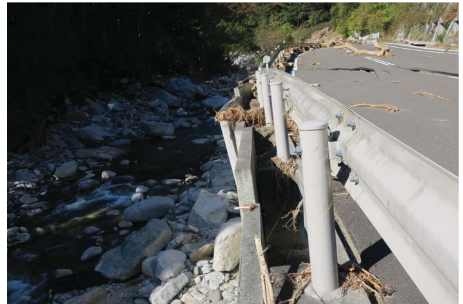
五福谷川、プレキャスト擁壁の損壊
