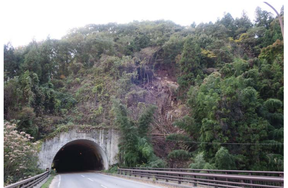
川張1号トンネル坑口の崩壊
