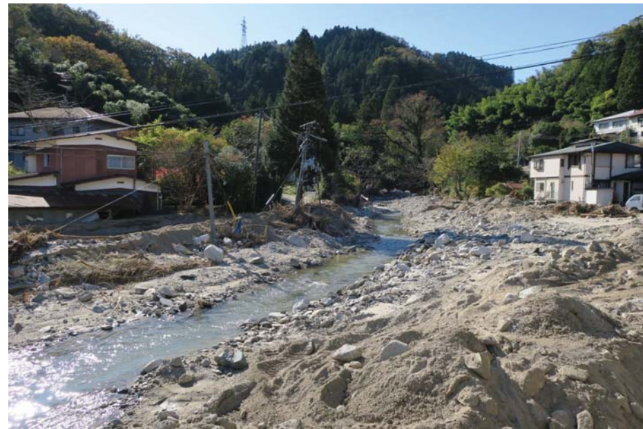
土砂洪水氾濫の状況（新川）
