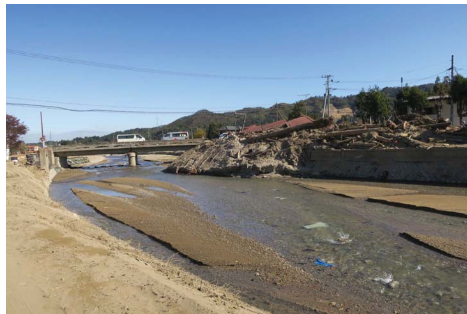
土砂洪水氾濫の状況（五福谷川）
