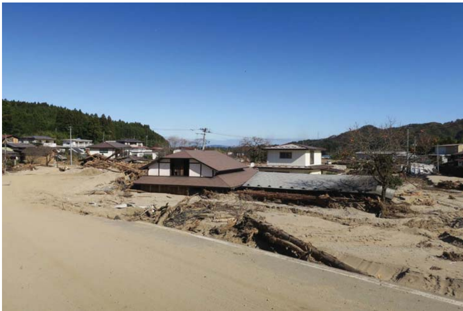
土砂洪水氾濫（岩下橋）
