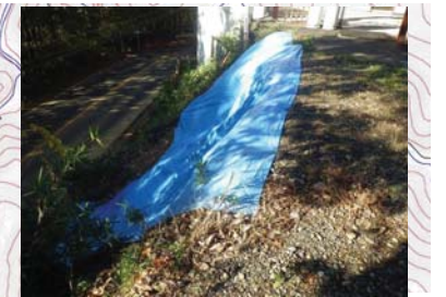
⑤県道76号道路からの流入水による表層崩壊
