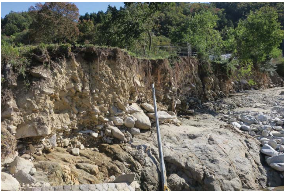
過去の土石流堆積物（五福谷川・薄平）
