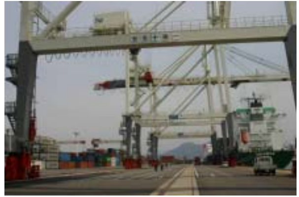
写真 - 6.26 アイランドシティ国際コンテナターミナルの現況
