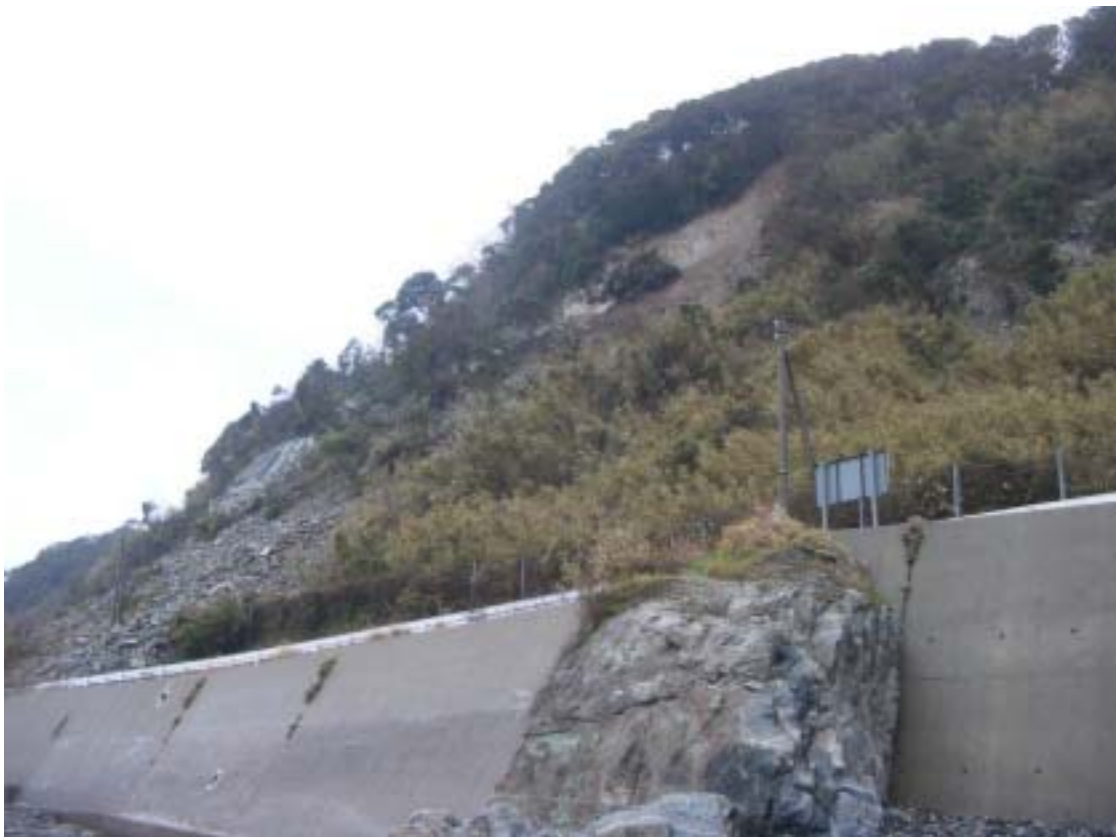
写真-5.6 斜面崩壊状況
