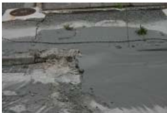
写真 - 6.4 荒津コスモ石油前での噴砂跡
