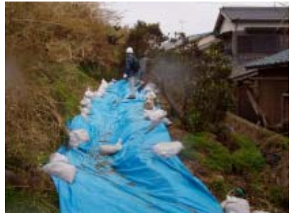
写真-4.2 頭部クラック
