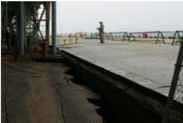
写真 - 6.27 須崎埠頭 (-11m) 岸壁背後の地盤沈下
