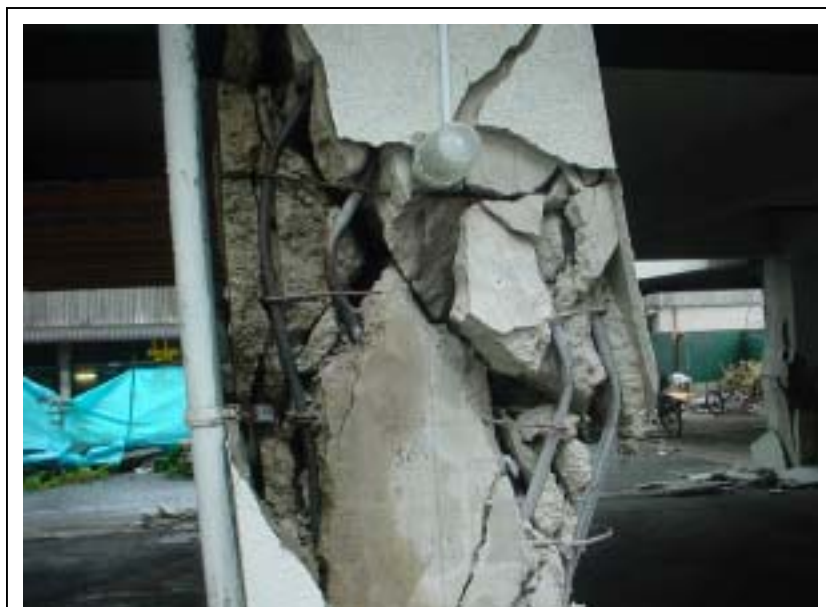
同上 1F ピロティー部 せん断破壊 拡大
