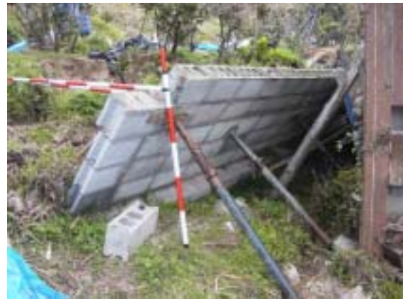
写真-4.4 斜面端部ブロック塀の崩壊
