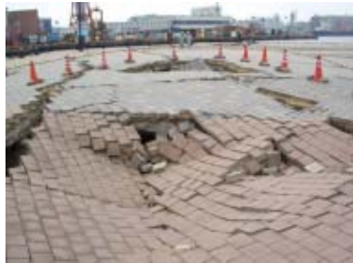
写真 - 6.14 中央埠頭イベントバースの被害状況
