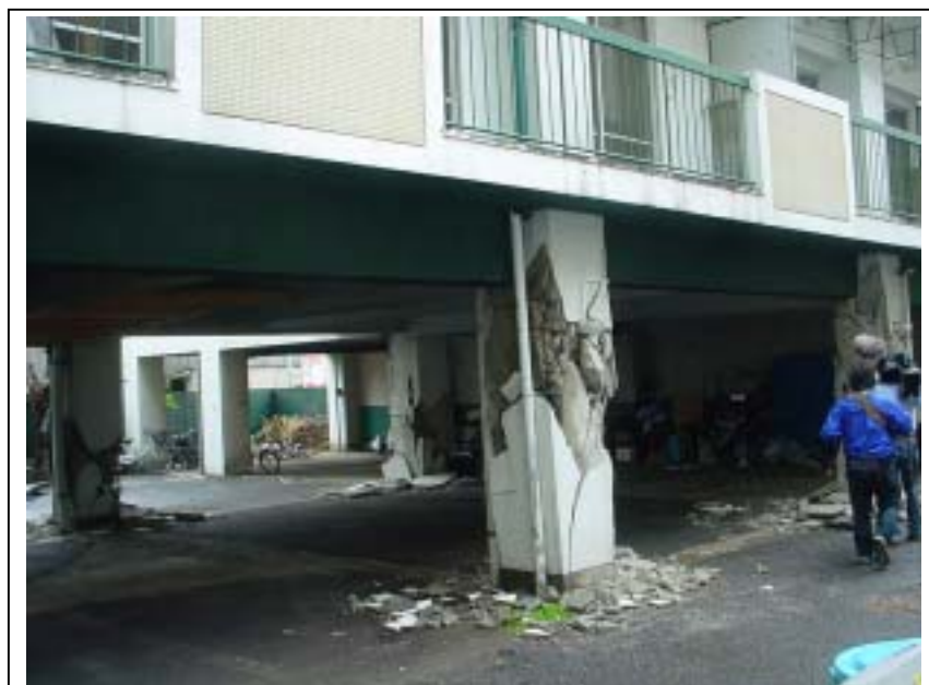
警固断層近傍のマンション 1F ピロティー部 せん断破壊
