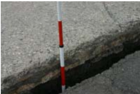
写真 - 6.15 箱崎埠頭 6 号岸壁の段差
