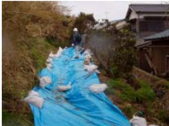
写真-4.1 斜面末端部ブロック積み擁壁の転倒による土砂の流出
