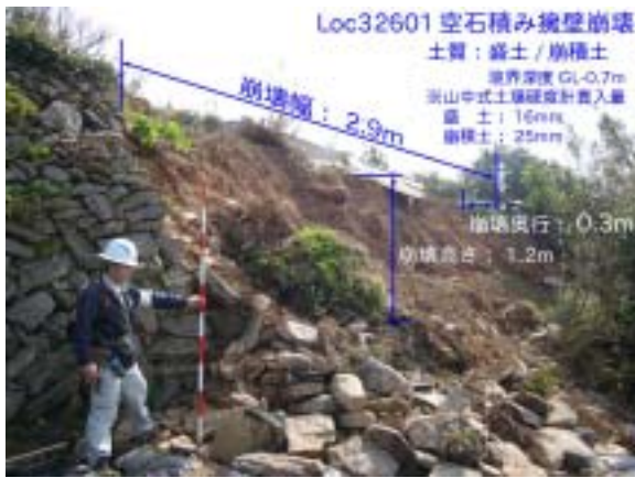
写真 - 3.14 Loc32601 空石積擁壁崩壊状況
