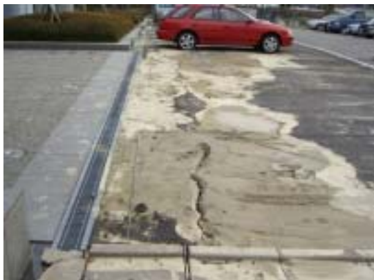
写真 - 6.1 百道浜 RKB 会館駐車場での噴砂跡
