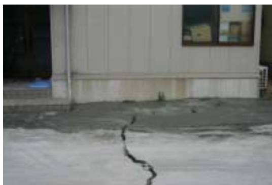
写真 - 6.6 中央埠頭7号岸壁の背後での噴砂跡
