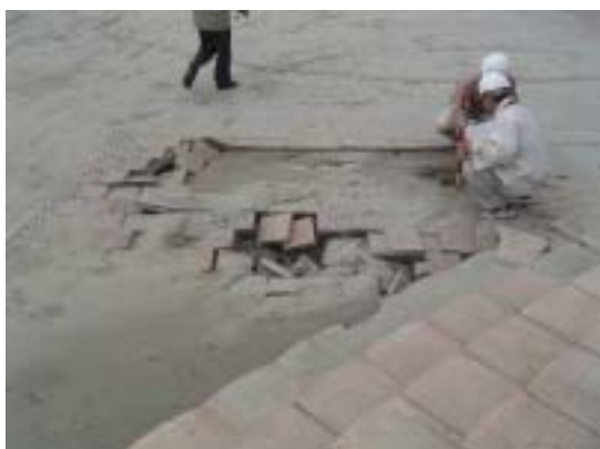
写真 - 6.5 中央埠頭イベントバスでの噴砂跡
