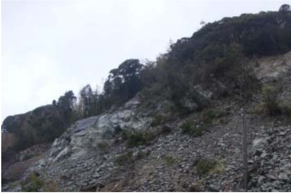
写真-5.5 斜面崩壊状況
