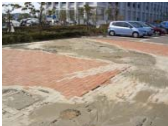
写真 - 6.2 百道浜 Panasonic 駐車場での噴砂跡
