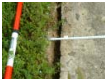
写真-3.2 擁壁変状状況
