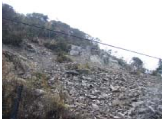
写真-5.4 斜面上部の状況
