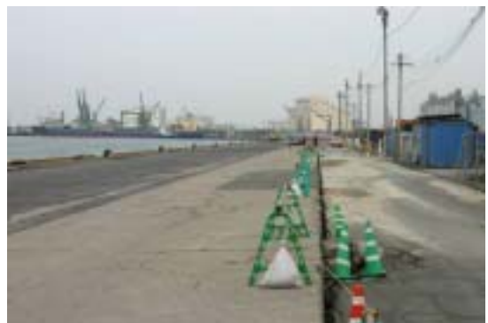
写真 - 6.16 箱崎埠頭 6 号岸壁の被害状況
