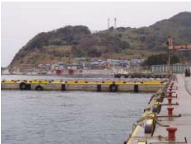
写真 - 4.5 西浦地区全景
