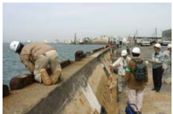
写真 - 6.29 中央埠頭 7号 (-5.5m) 岸壁法線のはらみだしと背後地盤の沈下状況
