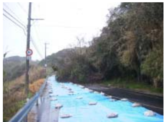
写真-5.2 道路陥没状況
