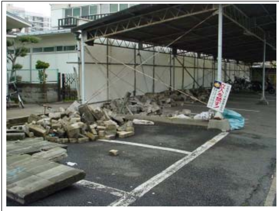
警固断層近傍の無筋ブロック壁(南北向き)の転倒
