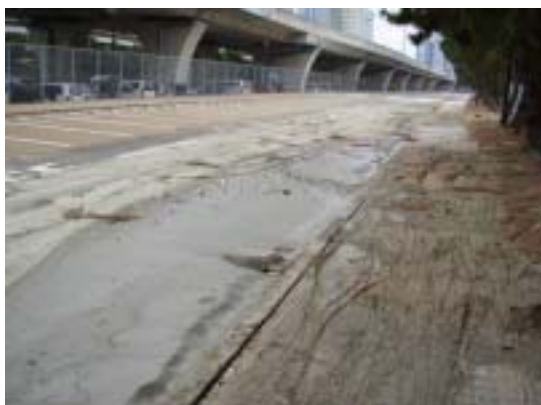
写真 - 6.3 ヤフードーム裏シーサイドももち 海浜公園駐車場での噴砂跡
