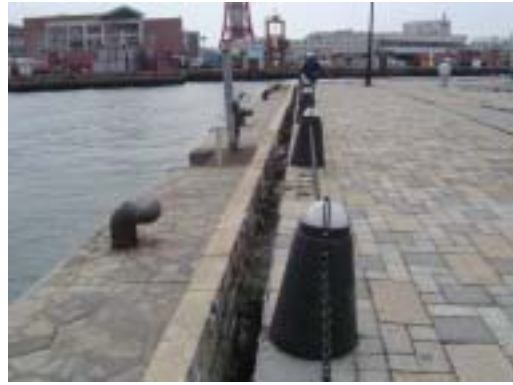
写真 - 6.13 中央埠頭イントバースの被害状況
