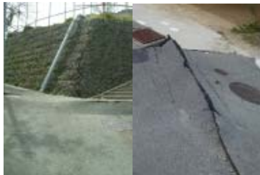
写真-3.4 擁壁の縦クラックおよび路面の隆起
