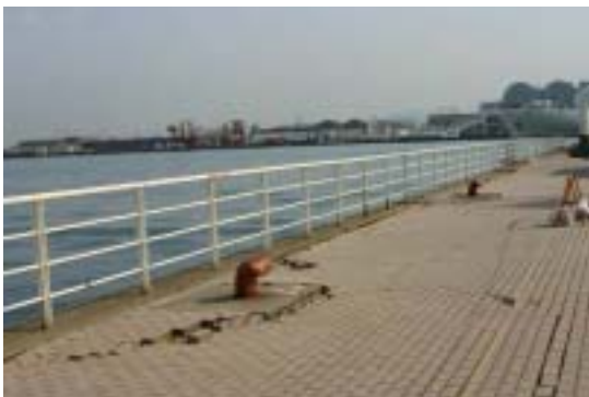
写真 - 6.17 博多埠頭先端部サンセットパークの被害状況
