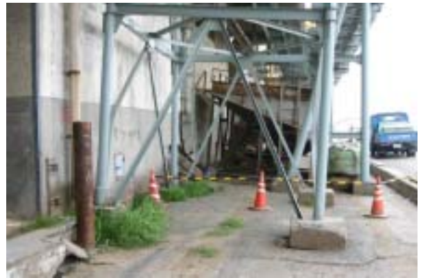
写真 - 6.28 須崎埠頭 (-11m) 岸壁背後の荷役施設の被害状況
