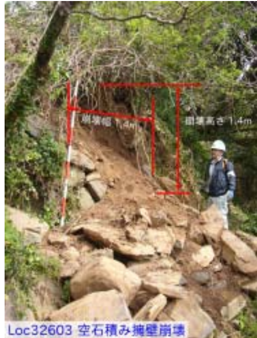
写真 - 3.16 Loc32603 登山道沿いの空石積擁壁崩壊状況
