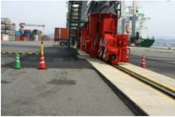
写真 - 6.25 アイランドシティ国際コンテナターミナルの現況
