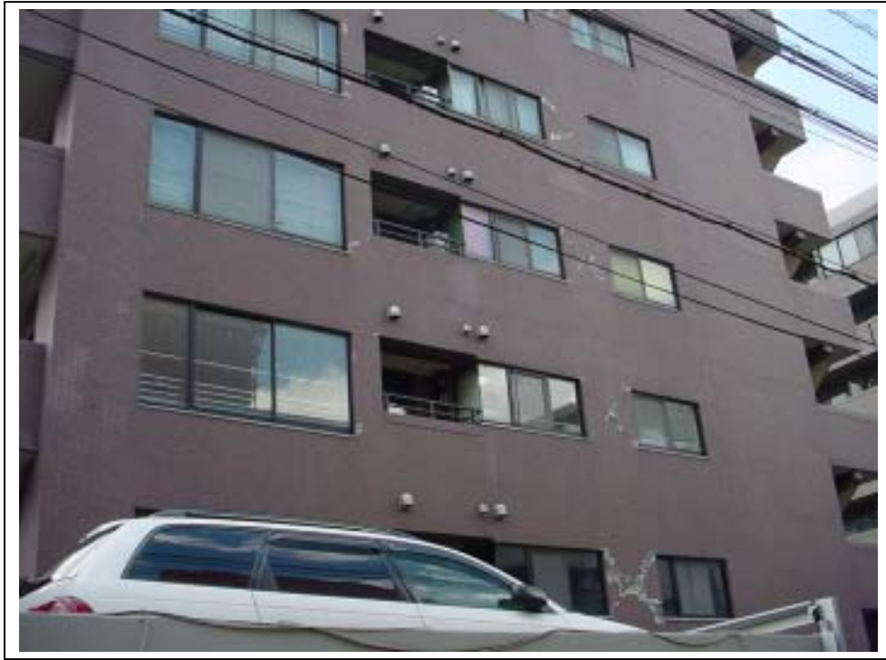
警固断層近傍のマンション 構造壁部 せん断破壊
