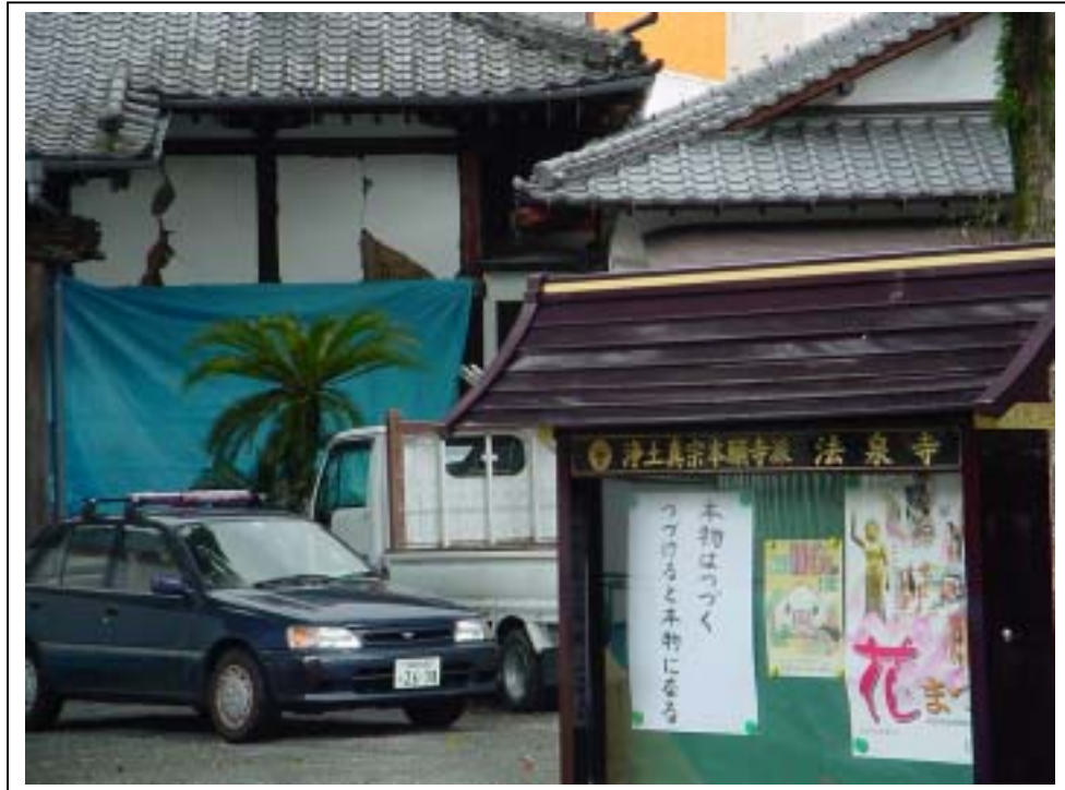
警固断層近傍のお寺 土壁の破損
