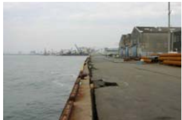
写真 - 6.11 中央埠頭 7 号岸壁の被害状況 (2005/3/21 撮影)
