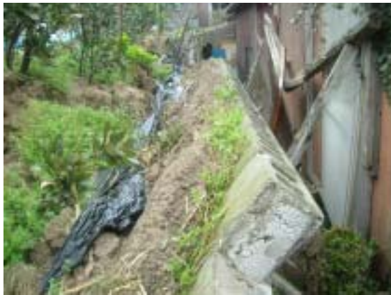
写真-4.3 斜面端部ブロック塀の崩壊
