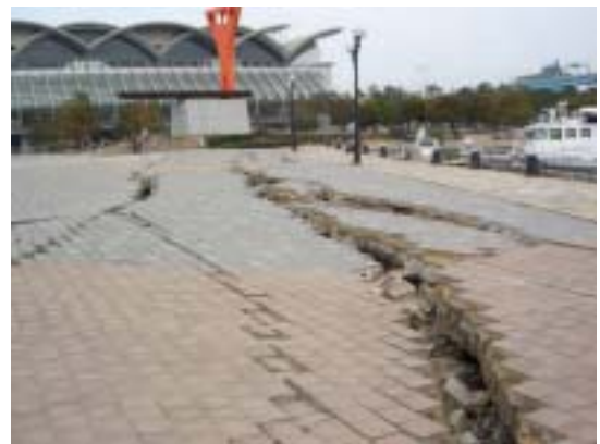
写真 - 6.23 中央埠頭イベントバースでの地盤の流動
