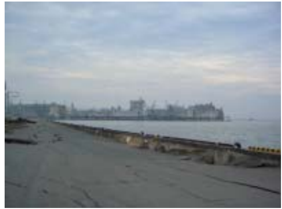
写真 - 6.9 中央埠頭 7 号岸壁の被害状況
