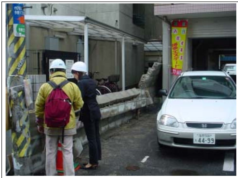
警固断層近傍の鉄筋入りブロック壁(南北向き)の転倒
