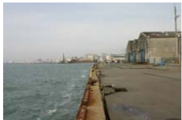
写真 - 6.12 中央埠頭 7 号岸壁の被害状況 (2005/3/26 撮影)
