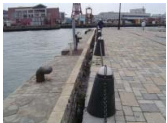
写真 - 6.24 中央埠頭イベントバースでの地盤の流動
