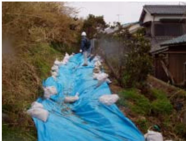
写真 - 4.6 斜面末端部ブロック積み擁壁の 転倒による土砂の流出
