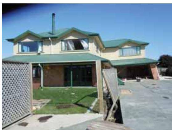
写真－4.12 造成盛土端部に位置する家屋の被害（図－4.1 の Point 116）
