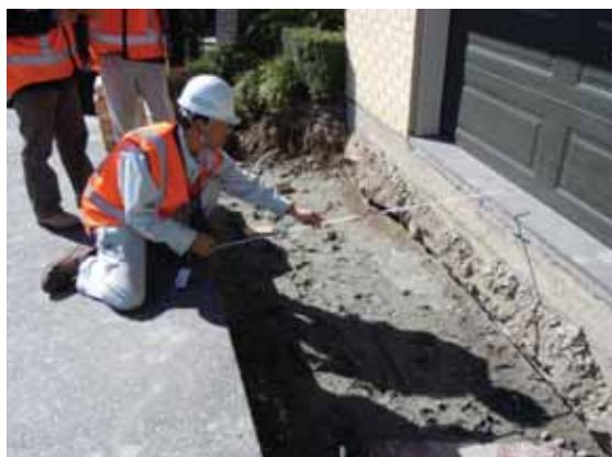
写真－4.11 造成盛土端部のスロープ上部に位置する家屋で生じたクラック（図－4.1 の Point 117）
