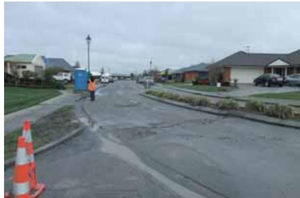
写真一付.11 Kaiapoi の住宅地（図-4.1 の Point 120 の北側）における液状化発生状況
