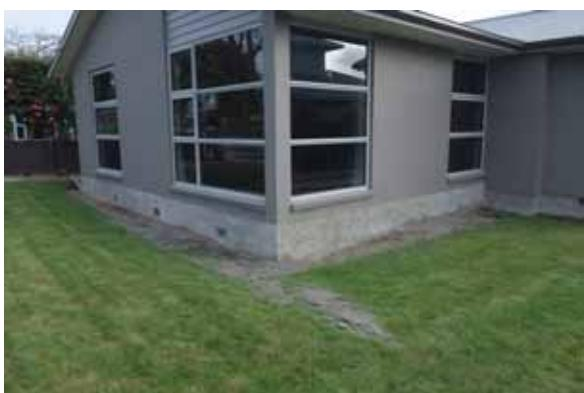
写真一付.5 液状化による家屋の沈下 (図一付.5 の Point C)
