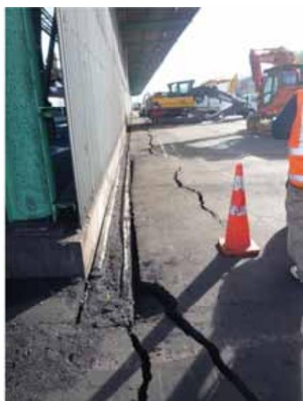
写真-5.7 背後の埋め土部に生じた地表クラック (図-
