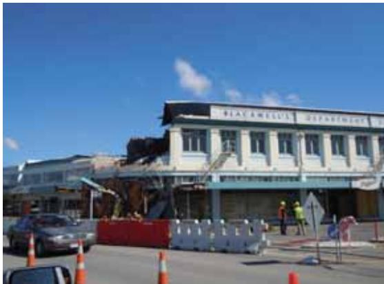
上記のような液状化による被害はこのエリア全体で多数確認されている。写真-4.7 (Point 111)の家屋にはクラックなどの破損は認められないが、家屋全体が 50cm 以上沈下した。正面の道路から家屋 1 階のガレージへのアプローチのスロープは下りとなっていたが、地震前は登りであったと報告されている。また、この付近では建設中の大型商業施設でも液状化により数 cm の沈下が確認された。この敷地内では地質調査業者による三成分コーン貫入試験が行われていた (写真-4.8, Point 107)。調査結果によると、この地域の地下水位は GL-1.5m 程度であり、GL-5m に分布する砂礫層までは非常に緩い砂層が堆積していることが確認されている。なお、この施設の対岸では液状化の発生は確認されなかったが、煉瓦造りの商店の二階部分が大きく崩壊していた (写真-4.9, Point 115)。
