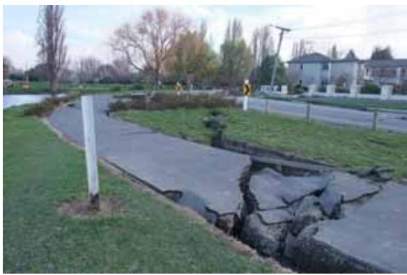
写真一付.3 Avon 川左岸の液状化による流動 (図一付.5 の Point B)
