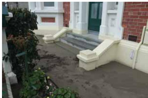
写真一付.9 Kaiapoi の中心地（図-4.1 の Point 111 付近）におけるビルの沈下状況
