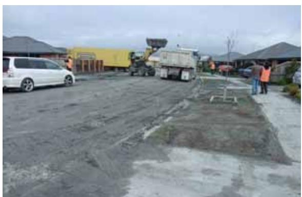
写真一付.7 Bexley の Seabreeze 地区(図-3.12 の Point 93 付近) における噴砂の搬出状況
