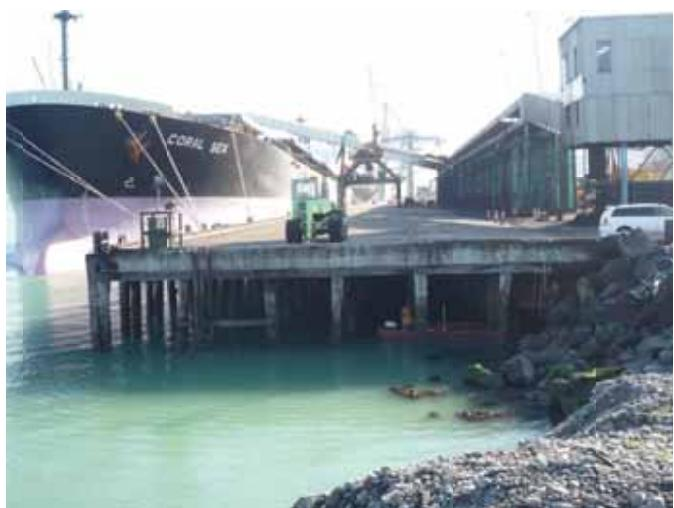
写真-5.5 位置図中 4 から見た石炭積み出し用護岸。杭は木杭である
