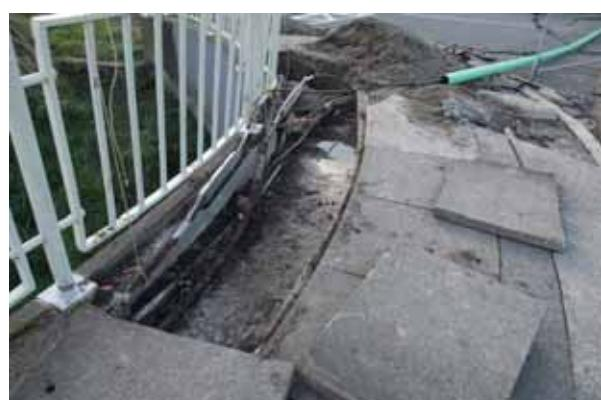
写真一付.2 橋の取り付け部のライフラインの被災状況
