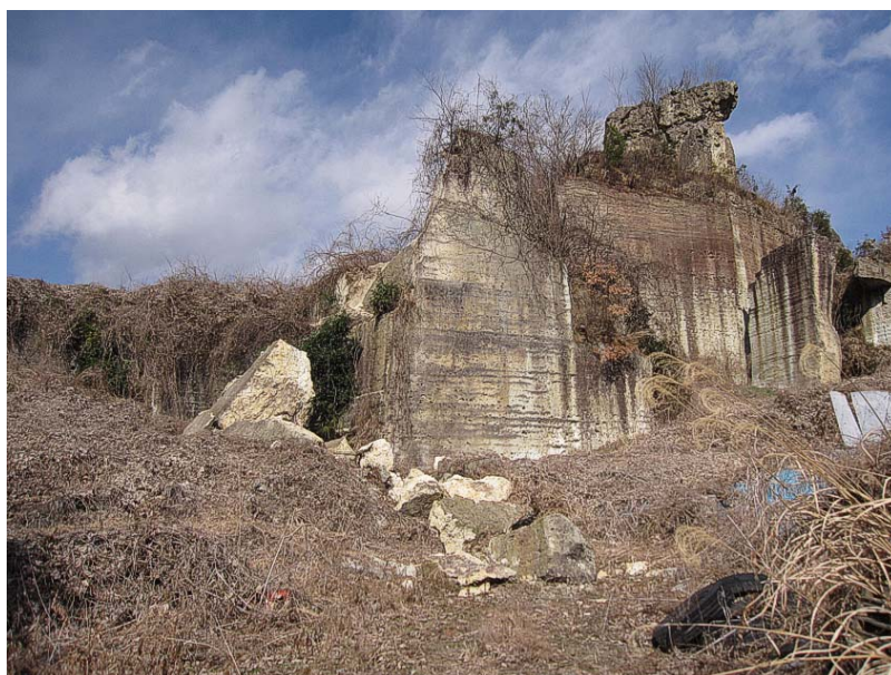
上記現場とは別の小規模崩落箇所（見学順路ではないので危険性はない）
