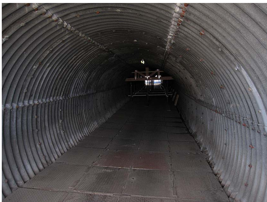
北側から内部を覗く（円形断面が右上—左下方向に圧縮、右下が沈下）
