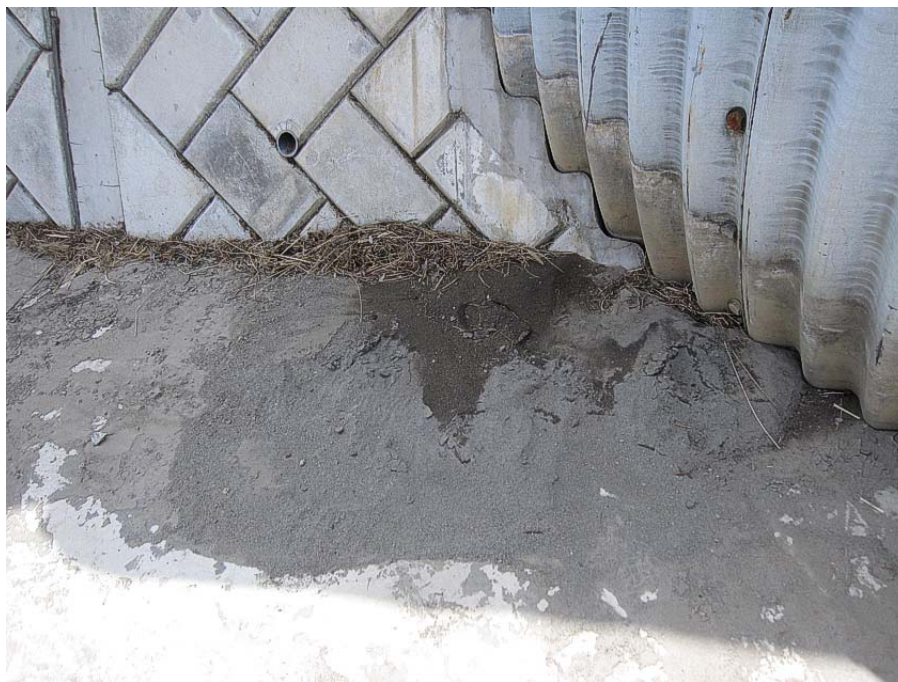
噴砂を疑われる痕跡（北側坑口基部）
