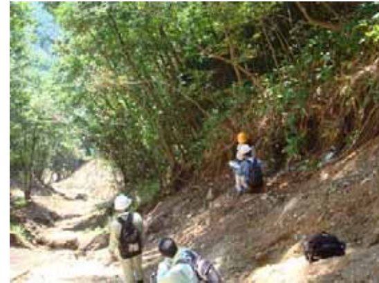
篠堂川の比較的大規模な右支溪の源頭部から 下流を見たところ。溪岸侵食の状況。
