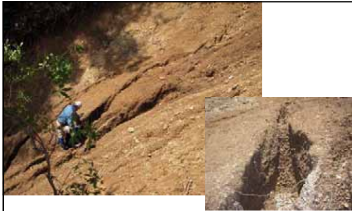
源頭部付近の谷底には礫が堆積 礫と基盤岩(流紋岩)との境界より湧水が滲んでいる
