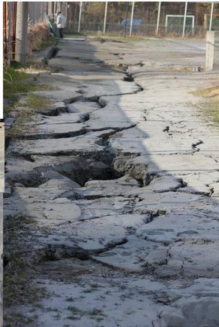
←噴砂や↑地割れが発生(習志野市の埋立地)
