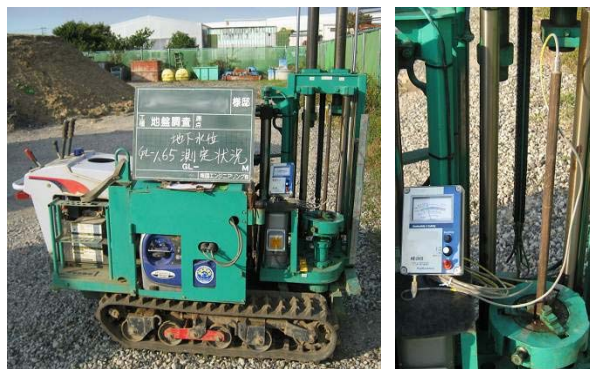
写真-1 SWS 試験孔を利用した地下水位測定状況
