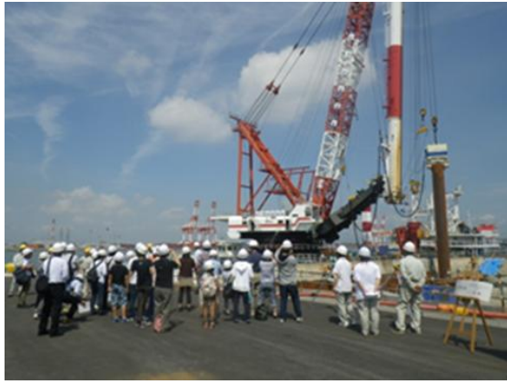
口絵写真-14 見学会 B コース・金城ふ頭再編工事の見学
