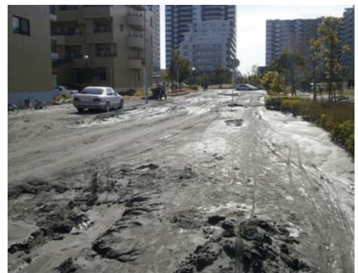
液状化の噴砂で砂場ようになった浦安市内
