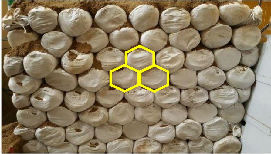
口絵写真-7 大型振動台を用いた加振実験における法先補強した盛土 (Case2) の土のう構造体 (プレストレス 75 \text{ kN/m}^2 ) (加振後もハニカム構造を維持)
