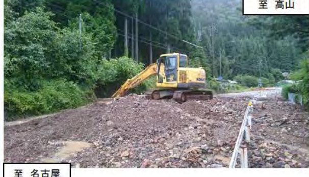
岐阜県下呂市金山町中切【国道41号86.9 kp】
