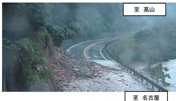
岐阜県下呂市金山町中切【国道41号89.4 kp】
