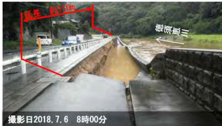
松浦川水系徳須恵川の護岸崩落（約110m） 国土交通省九州地方整備局提供資料
