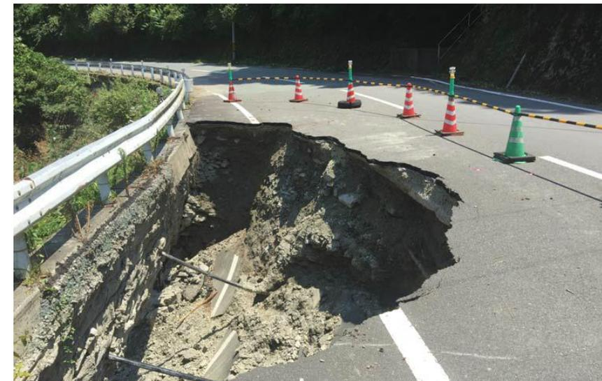
立川川増水による浸食で陥没した道路
