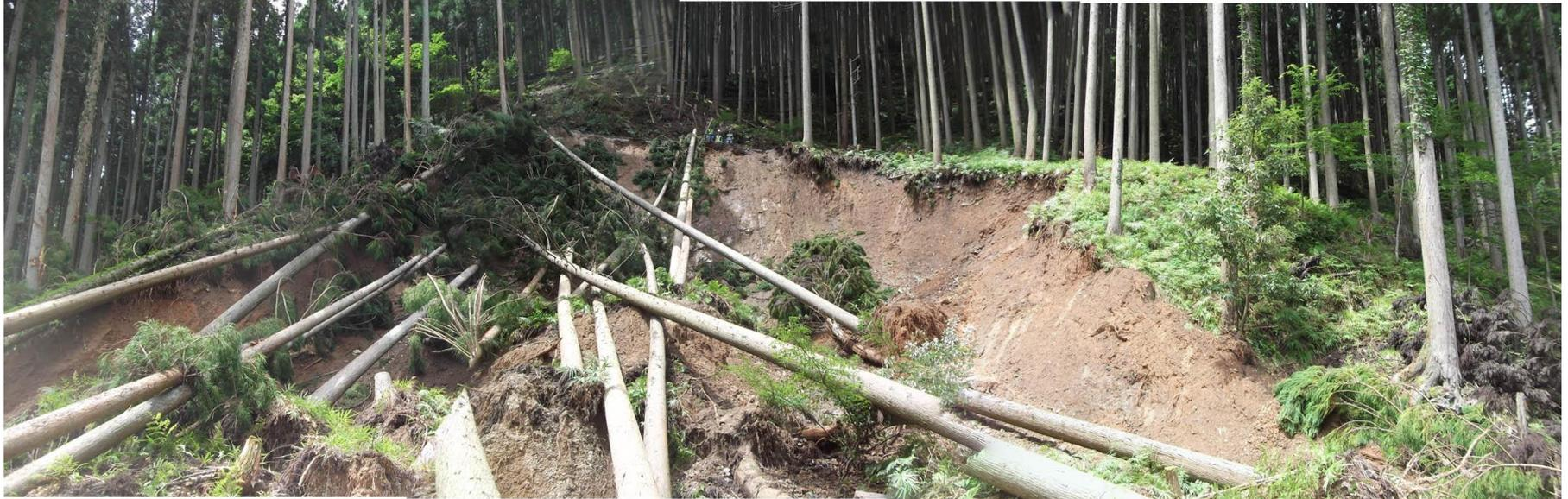
西牧山線沿い:幅35m、長さ45m程度の崩壊。道路谷側斜面が川に向けて大規模崩壊
