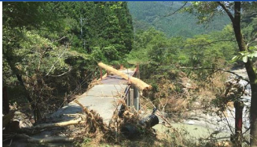
流木で手すりが流失した鋼桁コンクリート
