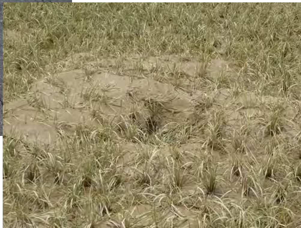
周辺の堤内地では噴砂・陥没
