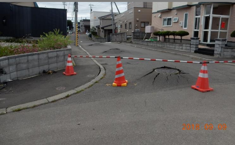
②：約30cm抜けあがった人孔（南東望） 周辺地盤の沈下
