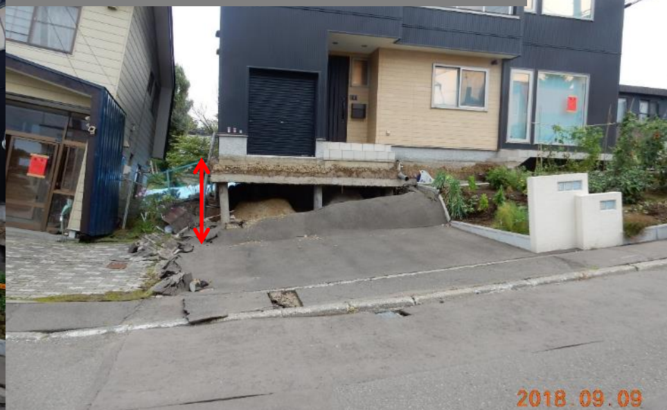
③：基礎から陥没面まで約1.8m
