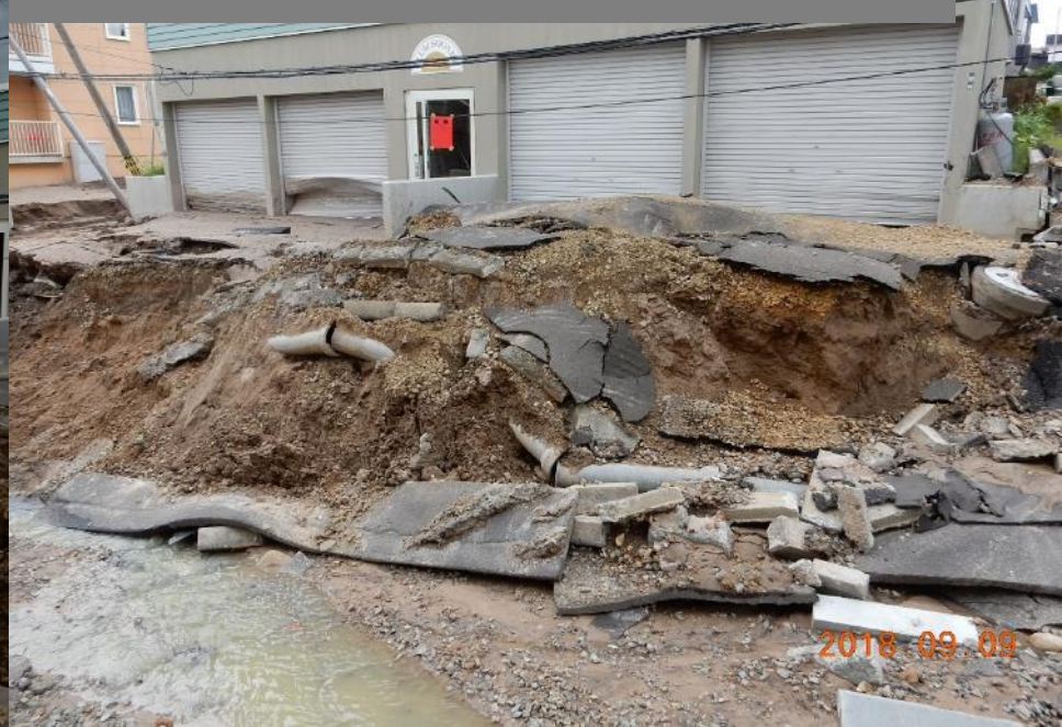
②：陥没箇所内に敷設された埋設管②
