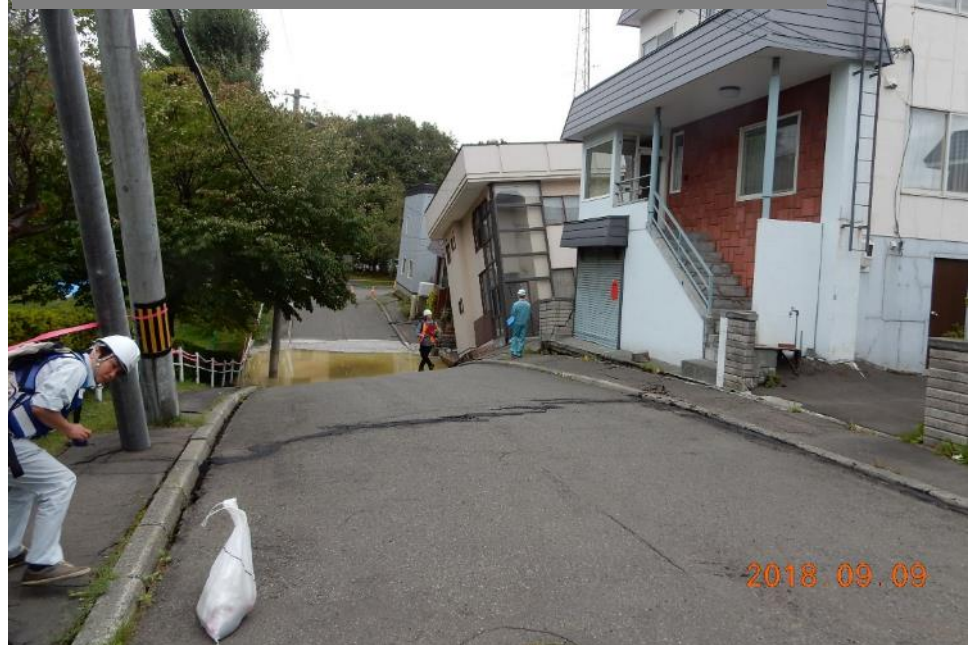
③：陥没上の戸建て住宅の傾斜 (めり込み沈下はない)
