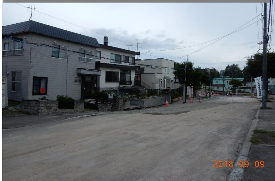
③：基礎から陥没面まで約1.8m
