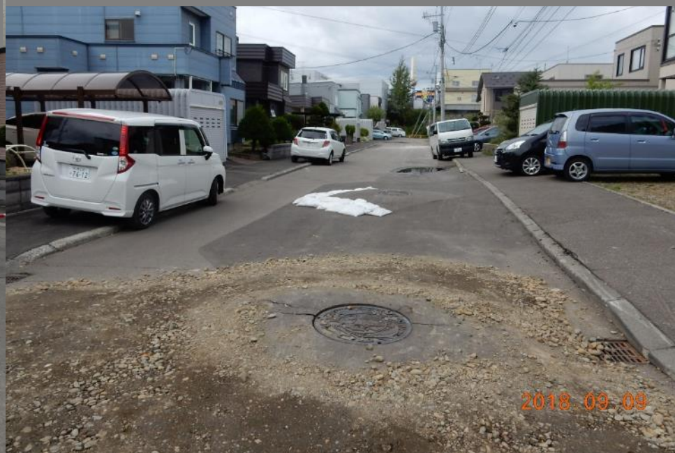
③：河川暗渠上の地表面の沈下（南西望）
