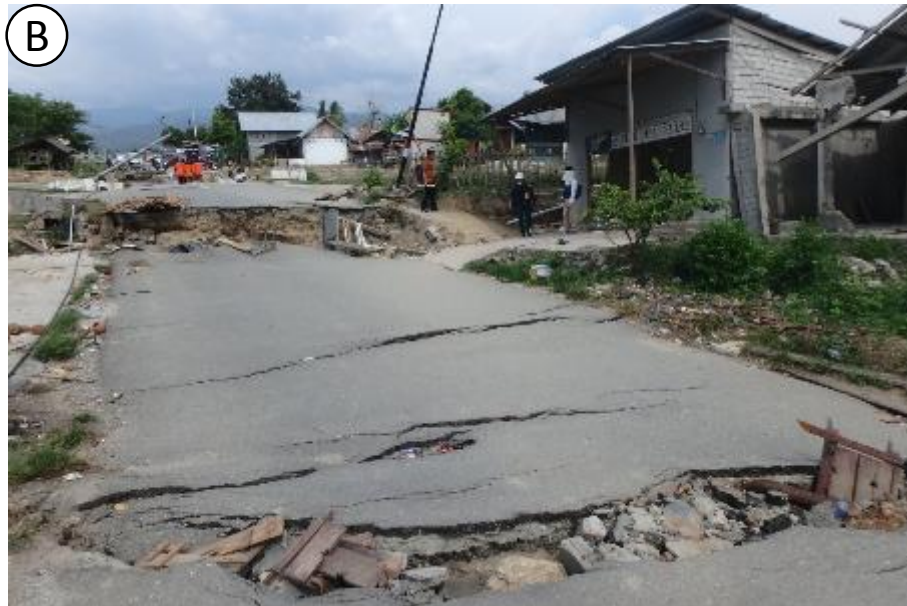
流動エリアの最上部で確認された、引張による多数の亀裂と段差。これらにより建物も大きく変状しているが、倒壊には至っていない。
