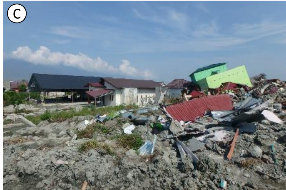
流動部の下流南側の端部の様子。巻き込まれなかった家屋の被害は軽微で、噴砂が確認された。ここではDCPT④を実施。
