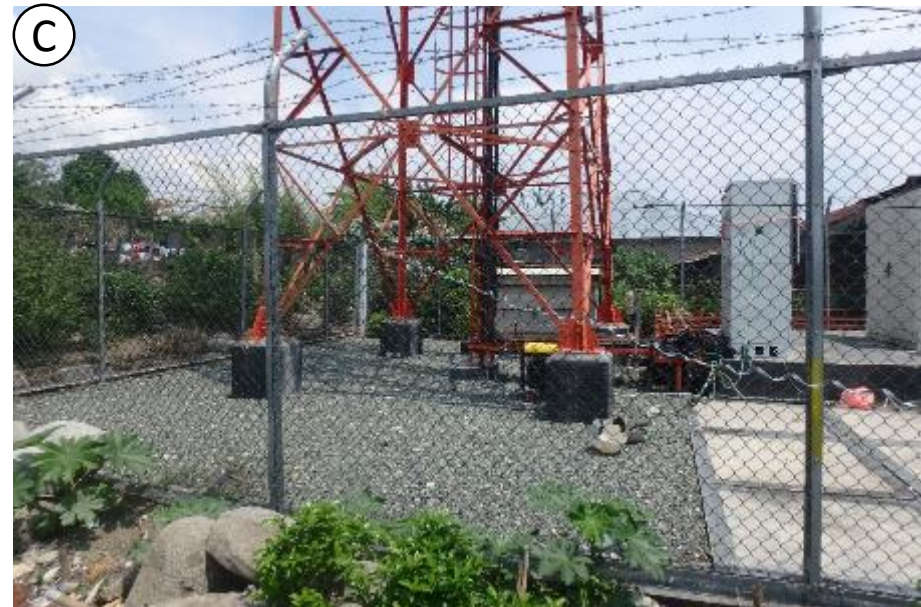
流動による上部亀裂の範囲から辛うじて免れた鉄塔。基礎や構造、周辺設備には異常は見られない。
