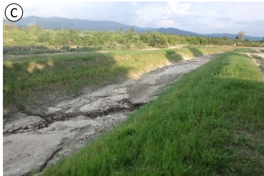
流動部の直上にある用水路の被害。噴砂の痕跡あり。用水路の被害は流動とは無関係の可能性もある。
