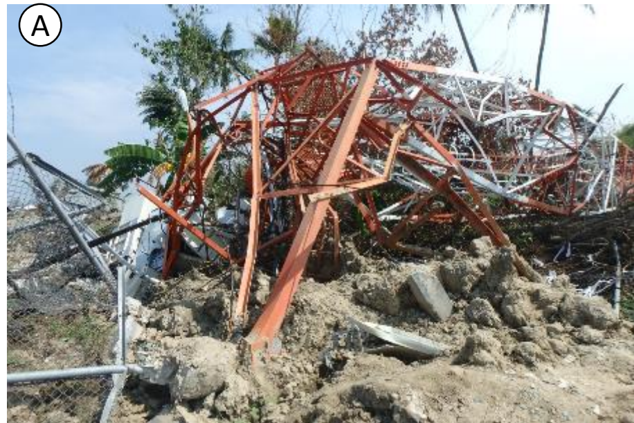
上流から流下してきた鉄塔(流動距離1100m)。基礎がそれぞれ大きく変位し上流側に倒れている。
