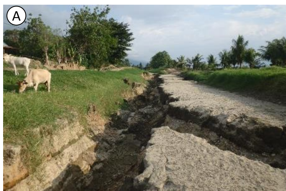
流動部の上部北川の用水路の被害。地震時には水が流れていた。数mの亀裂が河床に沿って伸び、斜面下流側の堤体は沈下。
