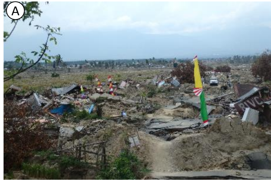
流動上部の大きな滑落崖を降りた位置で撮影。奥行き方向に流動しているが、勾配は非常に緩い。地震前の地表面勾配は約2%程度。
