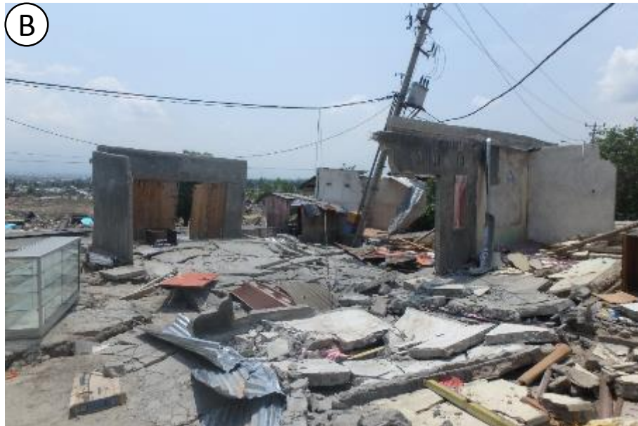
流動の最上部の家屋は、地盤の変状により引き離されて倒壊。地面にも引張り亀裂と数十cmの段差が斜面直交方向に多数生じる。
