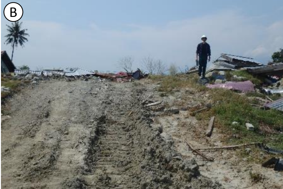
圧縮による隆起が数mに達している。証言によると、流下しながら沈下と隆起が繰り返され、それに伴い地盤の亀裂が開いたり閉じたりした模様。
