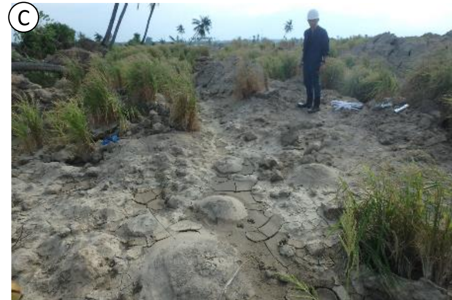
上記のDCPT地点よりやや下流部で噴砂と水が浸み出た痕跡を確認。地表面は1~2m程度の高さの起伏が続く。DCPT③と試料採取を実施。
