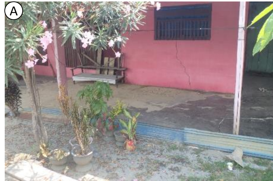
流動上部、北側の家屋で液状化による噴砂の痕跡を確認。噴砂の程度は小規模であった。流動部から連続する小さな亀裂が多数あり、危険。
