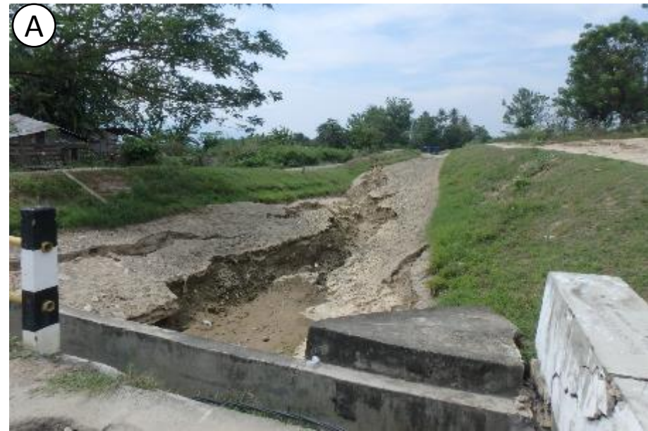
Jono Ogeと同様、流動の上部には灌漑用水が南北にあり、河床に大きな亀裂と下流側堤体の沈下が確認された。
