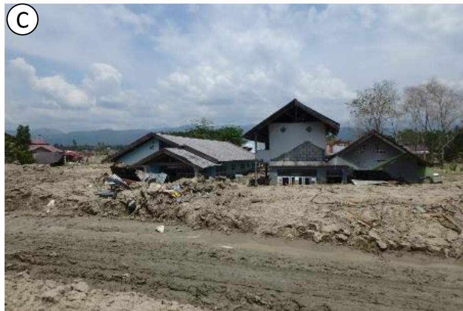
南側のエリアは上流から流下した土砂が埋まただけの家屋が目立ち、この場所の地盤の流動は無かった可能性が高い。
