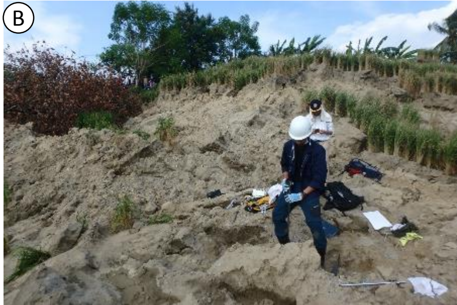
流動に伴う引張り・沈下で生じた滑落崖の高さは約5m程度。ここでは地表面は比較的乾いている。DCPT②を実施した(結果は後述)
