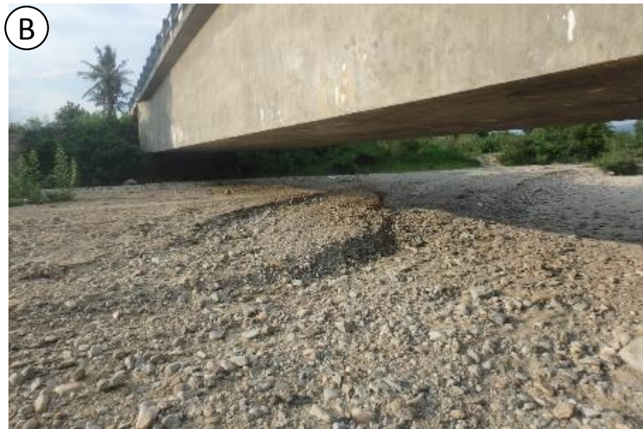
流動の南側に平行して流れる川。地震時も現在も、この位置では水は無い。用水はコンクリート橋で越えるが、橋に被害は無い。河床に変状なし
