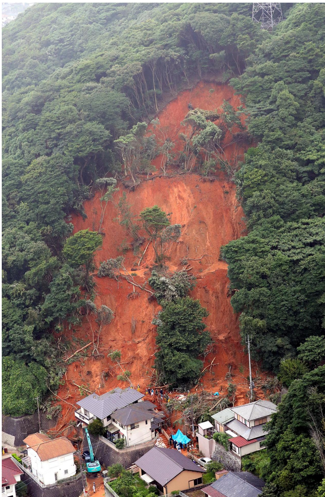
口絵写真-1 土砂が住宅に流れ込んだ現場=2018年7月8日午前11時25分、北九州市門司区、朝日新聞社ヘリから (撮影：堀英治，朝日新聞社提供)
