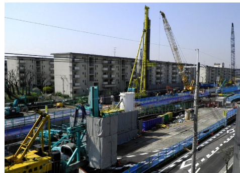
地中連続壁工（TRD）・中間杭工
