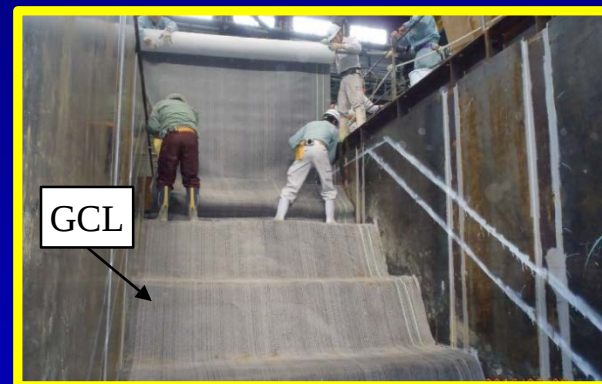
堤体モデルへのGCL敷設状況
