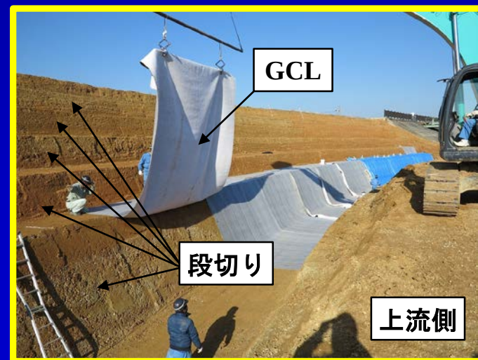
ベントナイト系遮水シート（GCL） の敷設状況（兵庫県）
